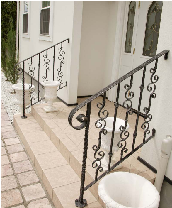
外部手摺施工例
