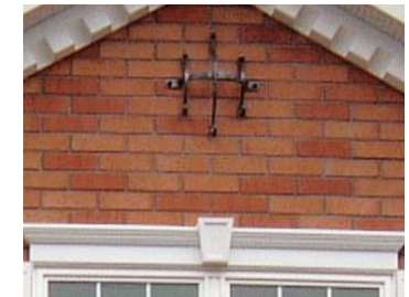
妻飾りAタイプ施工例
